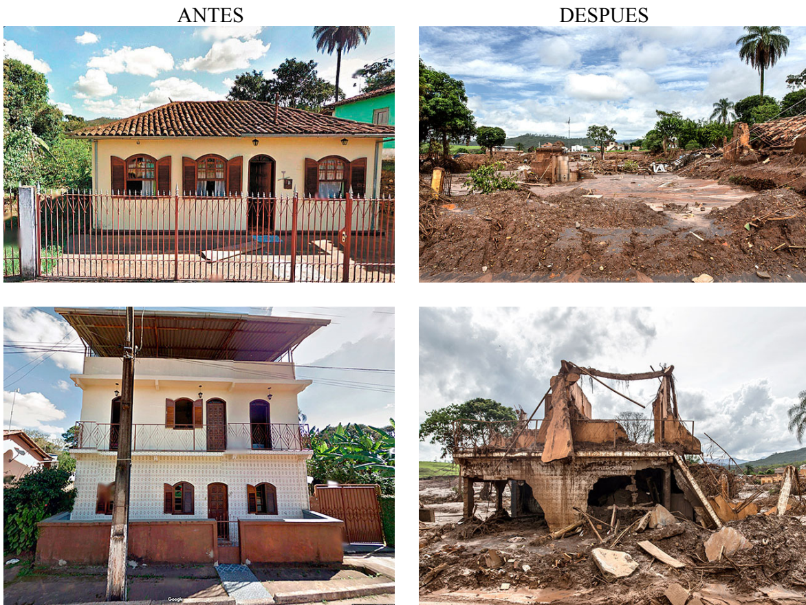
Figura 1.- Imágenes de edificaciones en Bento Rodrigues, Brasil, antes y después de la rotura de las presas Fundão y Santarem el 5 de noviembre de 2015 ( Folha do São Paulo ).
