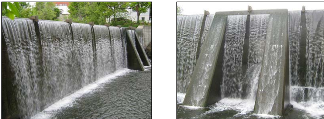
Figure 1 : Différentes vues du barrage à l'étude
