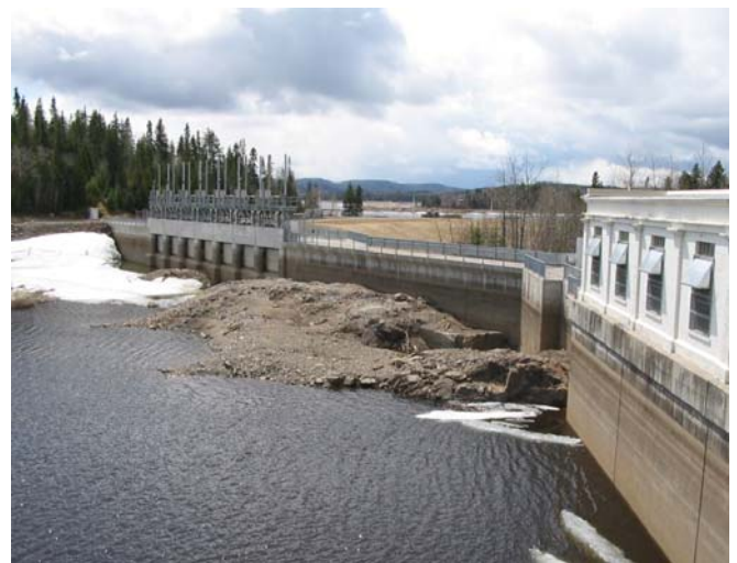
Figure 13. Barrage Pibrac Est
