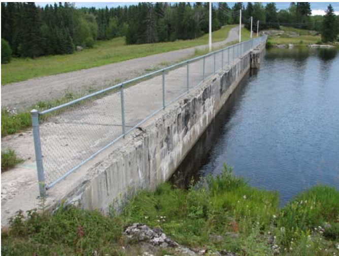
Figure 10. Digue Pibrac Ouest
