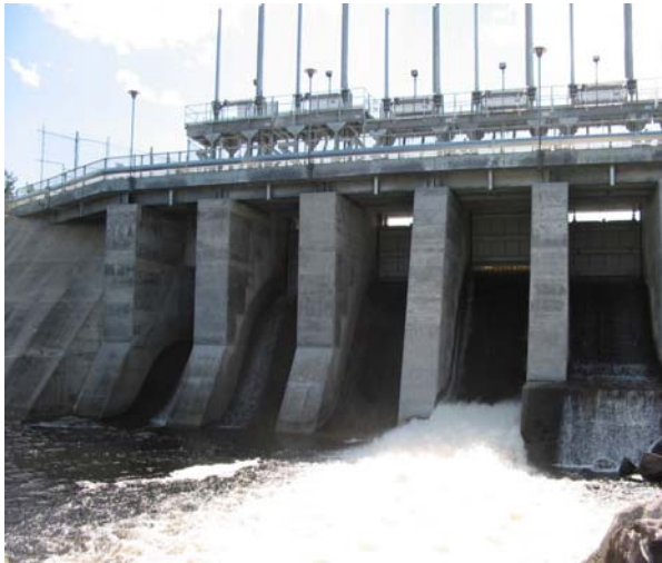
Figure 12. Barrage Pibrac Ouest
