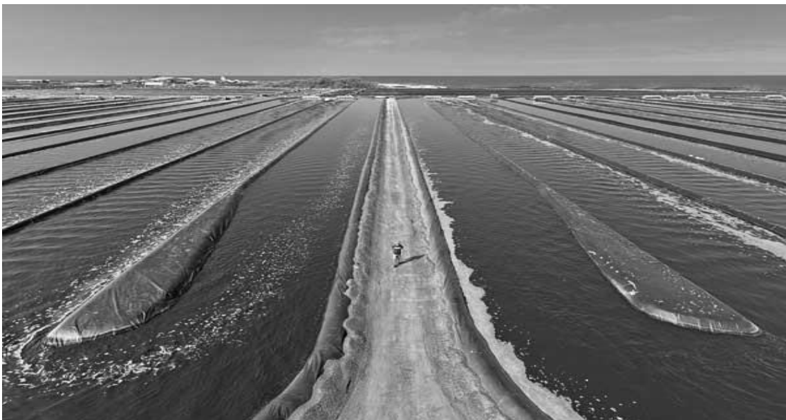
圖 4-14 機翼剖面型彎道頭隔板，Neil Savage(Nature 2011)
