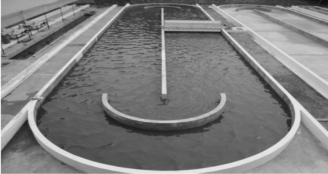
圖 4-13 具半圓弧形導流板的微藻養殖池(Aban Infrastructure Pvt Ltd)
